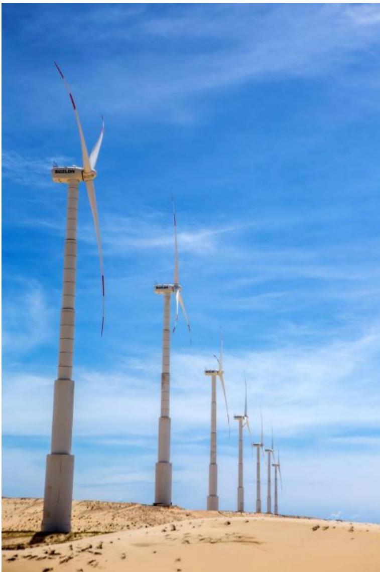
Usinas eólicas têm sistema muito parecido com o de um catavento gigante. Foto: Soninha Vill/GIZ
