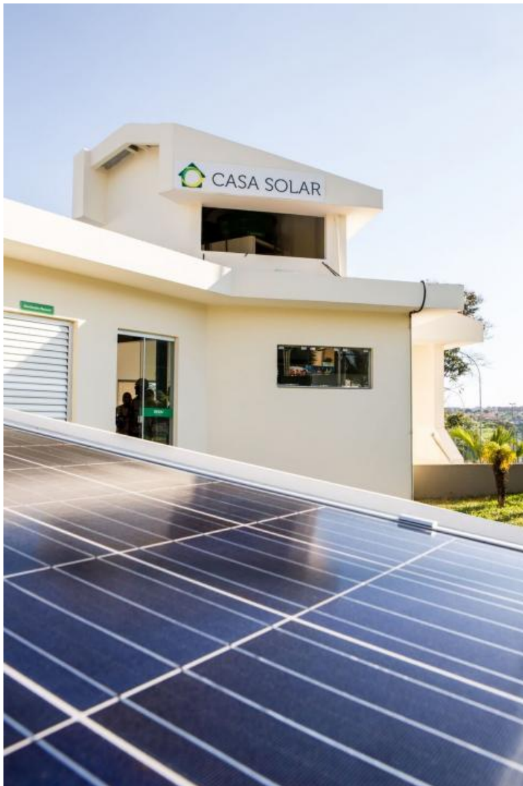
Casa Solar: convênio transformou local em centro de treinamento de energias renováveis. Foto: Soninha Vill/GIZ
